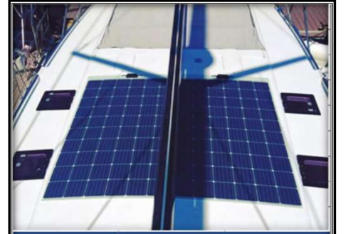
Yelkenli / Güverte Üzeri Montajı
