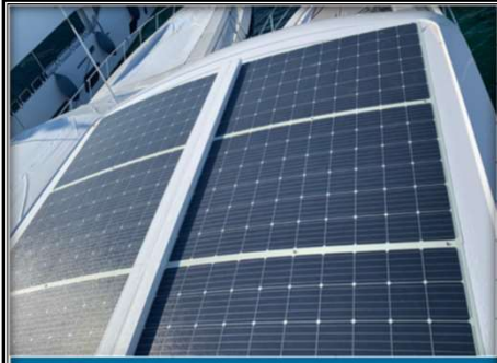
Motoryat / Hard Top Montajı
